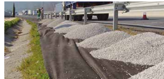
10.000 m 2 de Plantex® Premium le long de l'autoroute de Barcelone à Saragosse.
